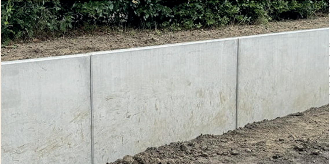
Kerend L-element beton, particulier eigendom
