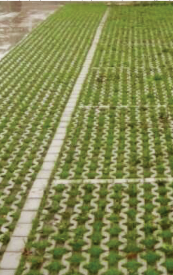
Gescheiden parkeervakken met strekkenlaag (gebakken materiaal)
