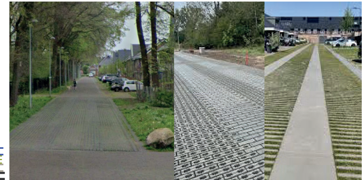
Afwijkende verharding of alternatief bestratingsverband t.h.v. doorsnijding groenzones als (visuele) snelheidsremmer. Referentie naar karrenspoor.
