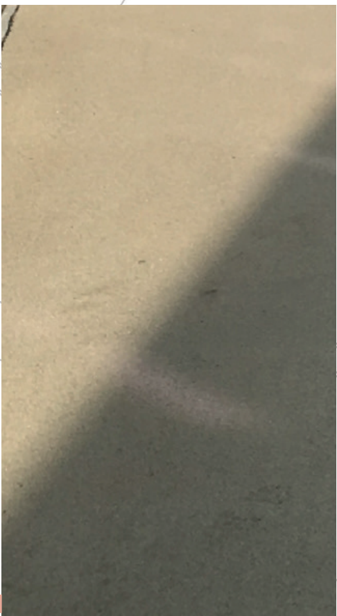
Fietspad geel asfalt
